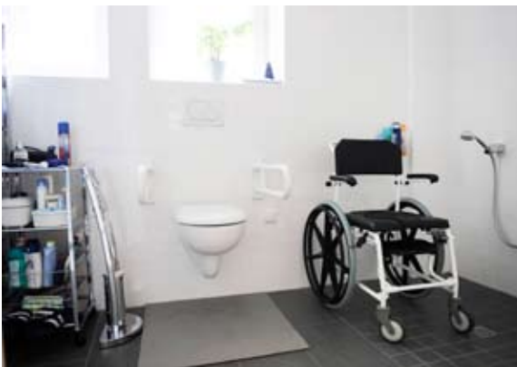
Nachher: Gäste-WC und Badezimmer wurden zusammengelegt, sodass ein großer freundlicher Raum entstanden ist.
