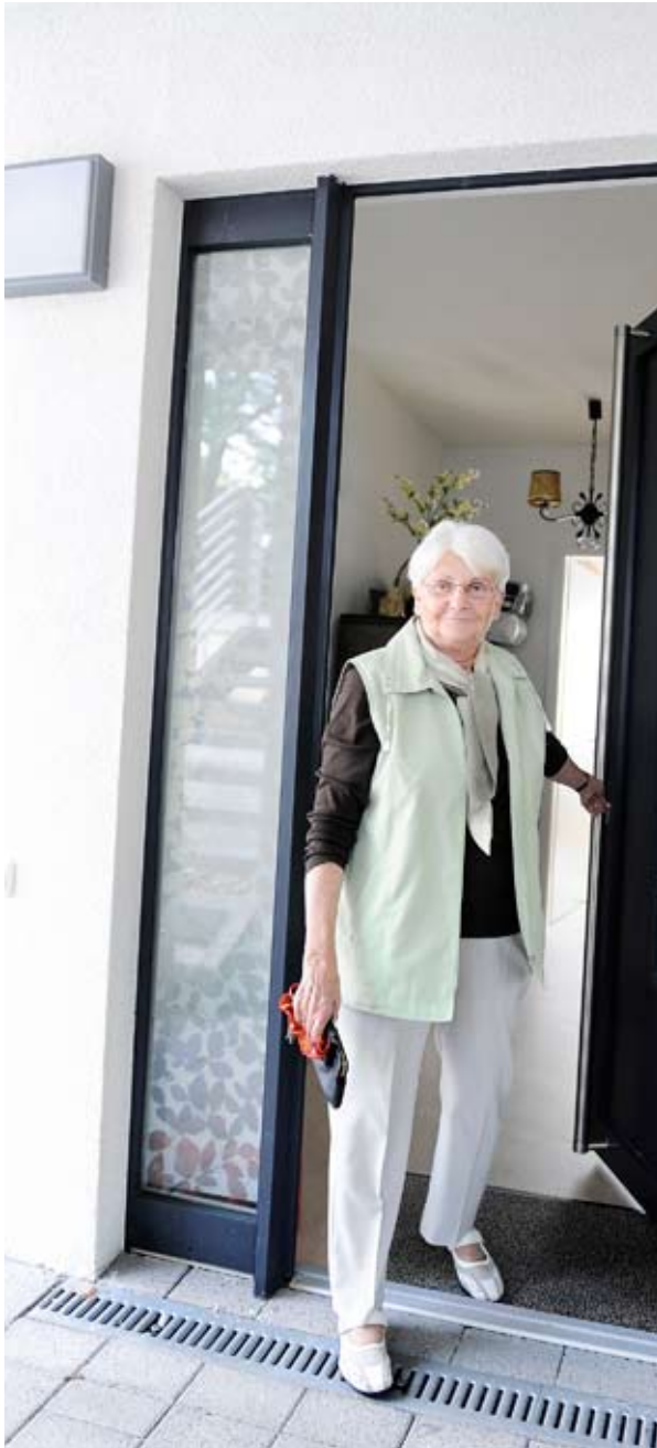
Ein schwellenfreier Zugang sichert die langfristige Selbstständigkeit.
