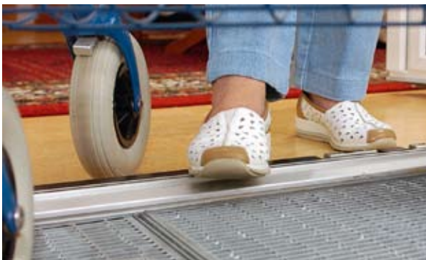
Schwellen dürfen nicht höher sein als 2 cm, damit der Umbau förderfähig bleibt.
