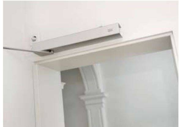
Mit einem automatischen Türantrieb sind Türen leichter zu öffnen.
