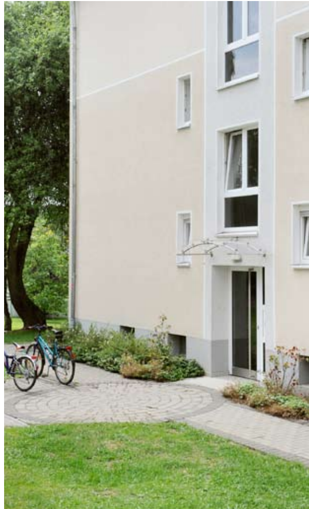
Ob Investitionszuschuss oder Darlehen – die Förderung der KfW für den altersgerechten Umbau lohnt sich für Jung und Alt.
