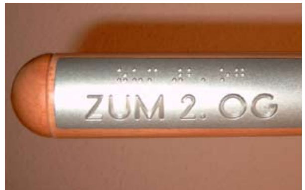
Taktile Markierung mit Braille- und Reliefschrift an einem Geländer.
