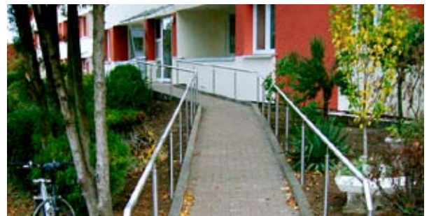
Nachher: Rampe mit Handlauf und Radabweiser.
