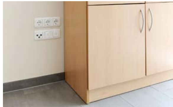
Auch Feinheiten wie das Anbringen von Gerätesteckdosen in mindestens 40 cm Höhe über dem Fußboden erleichtern das tägliche Leben.
