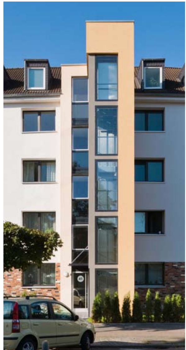
Mehrfamilienhaus mit nachträglichem Anbau eines Aufzugs.
