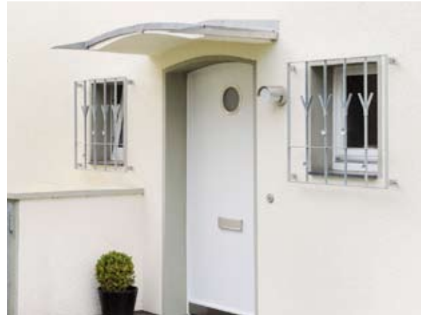
Ein Dach bietet Schutz bei Wind und Wetter.
