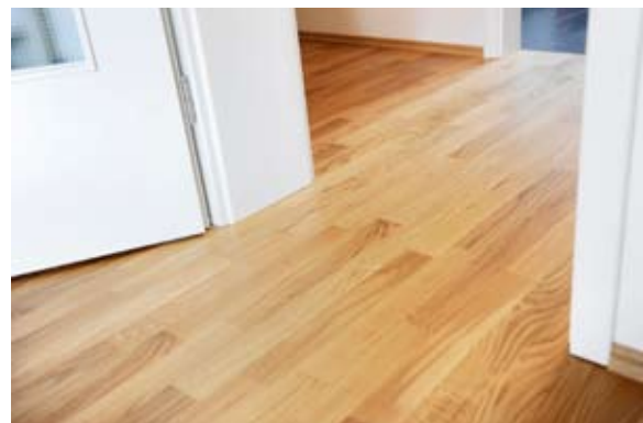
Die Übergänge zwischen allen Zimmern sind schwellenlos, so dass keine Stolperfallen mehr bestehen.
